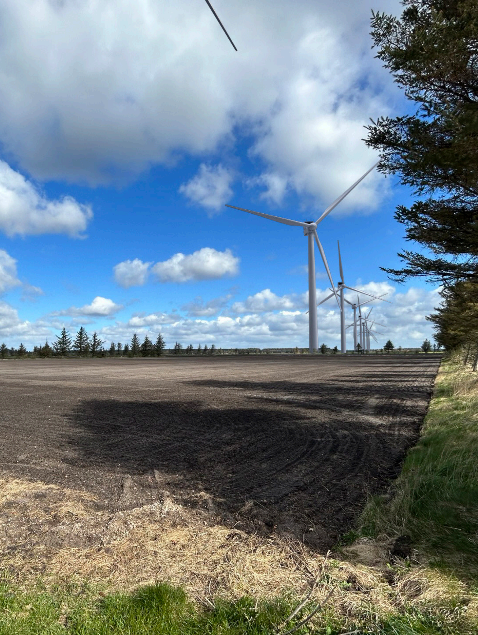
Visualisering 200 meter høje vindmøller med en rotordiameter på 162 meter, set fra Donskærvej mod nord
